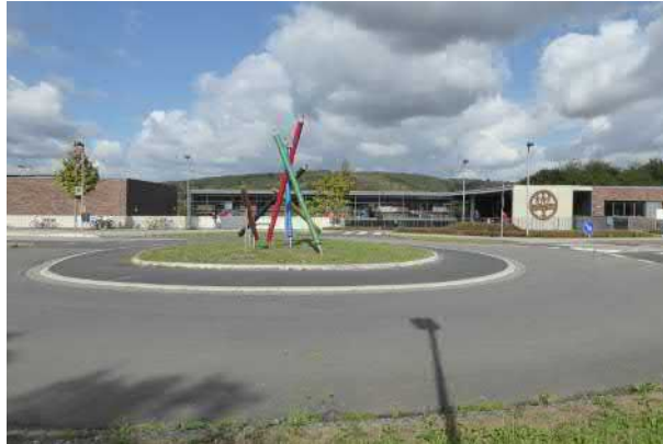
Abb. 3.5: GGS Siegtal: Blick auf das Schulgebäude
