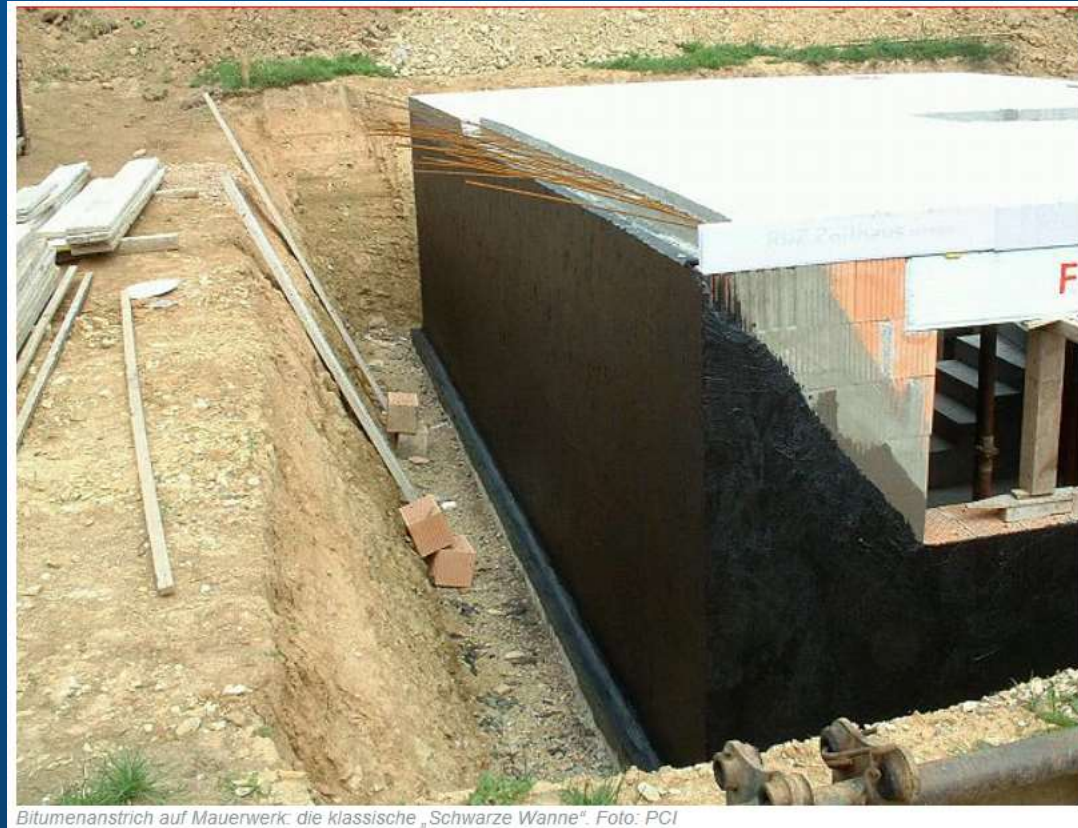
Bitumenanstrich auf Mauerwerk die klassische „Schwarze Wanne“. Foto: PCI
