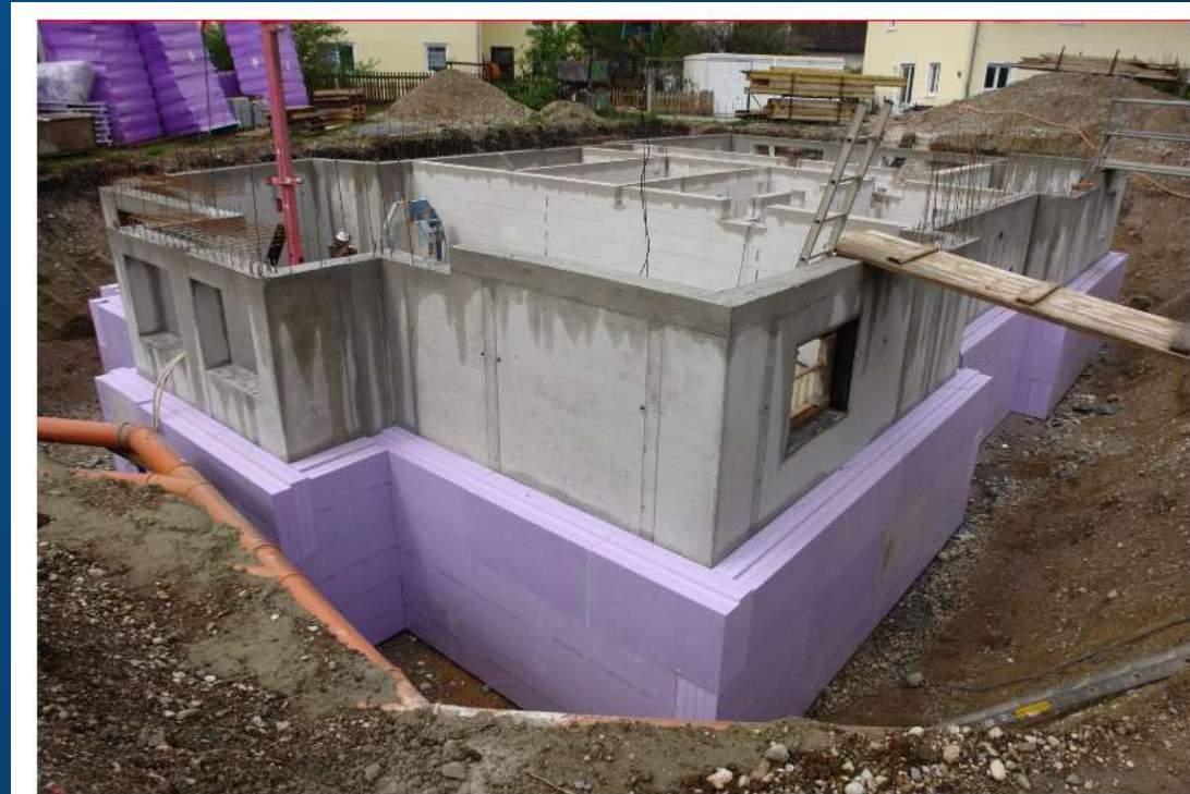
Perimeterdämmung aus XPS an einer Kelleraußenwand. Foto: FPX
